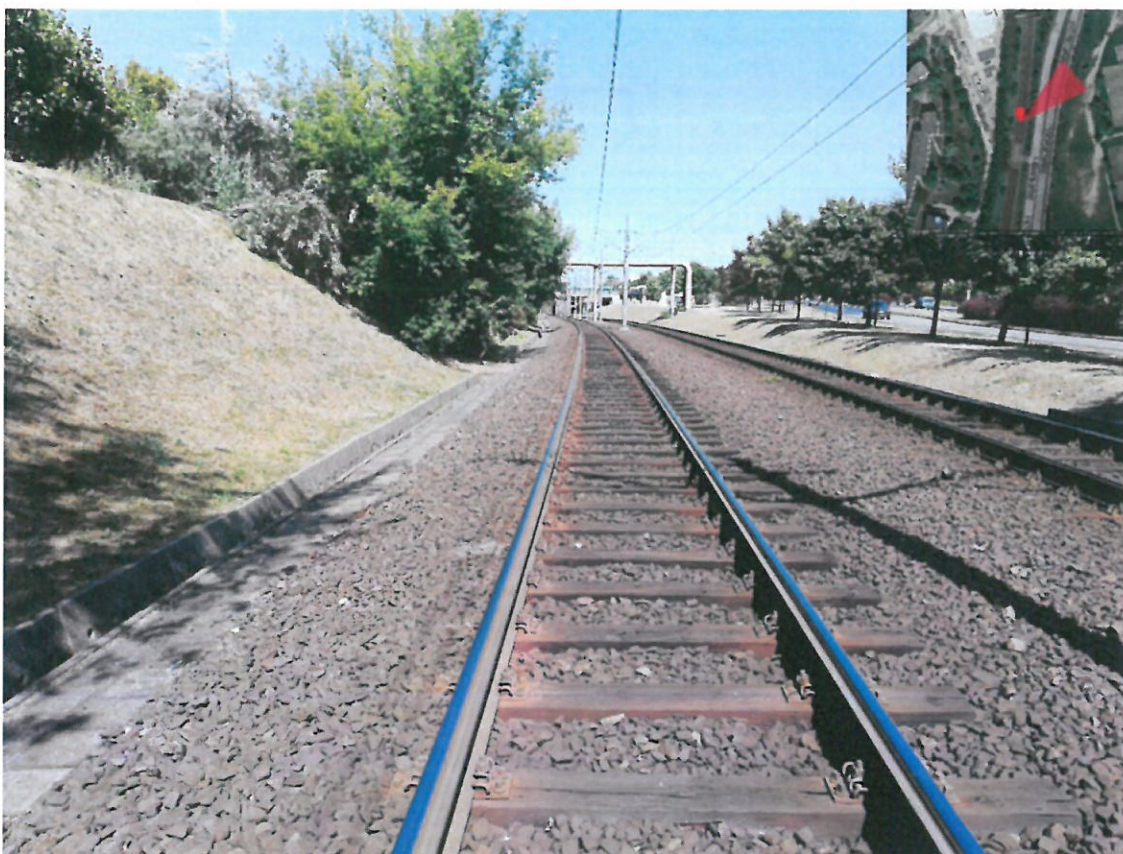
Fot.1. Stan istniejący – szlak (przed Przystankiem Słowiańska) – odwodnienie do rowów betonowych.
