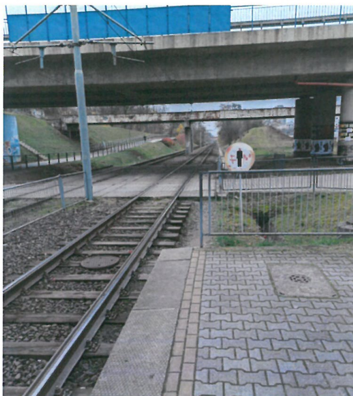
Fot.4. Stan istniejący - widok z Przystanku Lechicka w kierunku pętli Sobieskiego
